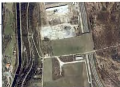
Strada Statale 336 Varese; Ecodotto
