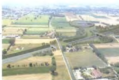
Tangenziale Esterna Est Milano Foto inserimento del cavalcavia presso Pessano con Bornago (Mi)
