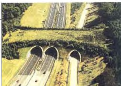
Autostrada A50 Paesi Bassi Ecodotto di Woeste Hoeve.
